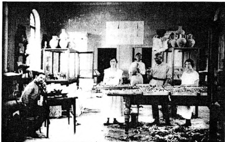
Рис. 2. Строительство экспозиции Херсонесского музея. 1925 г. Фото из архива НЗХТ.
