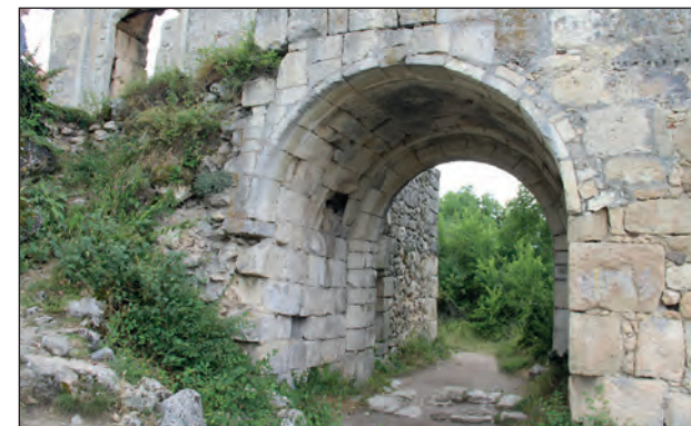
Рис. 1. Участок реставрации арки ворот цитадели 1974-1975 гг. Современное состояние. Фото А. Ю. Манаева (2017 г.)
