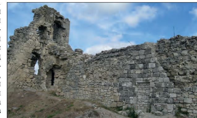
Рис. 4. Куртина Б цитадели Мангупа после окончания ремонтных работ. Фото А. Ю. Манаева (2011 г.)
