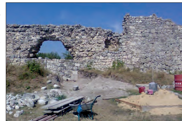
Рис. 3. Ремонтные работы на куртине Б цитадели Мангупа. Фото А. Ю. Манаева (2011 г.)
