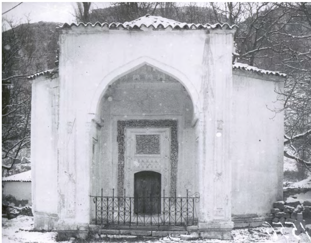
Рис. 6. Дюрбе Хаджи Гирея. Вид с юго-востока. Фото 1928 г. [по: 7, с. 251, рис. 813] Fig. 6. Türbe of Hadzi Girei. Viewed from the south-east. 1928 photo [after: 7, p. 251, fig. 813]
