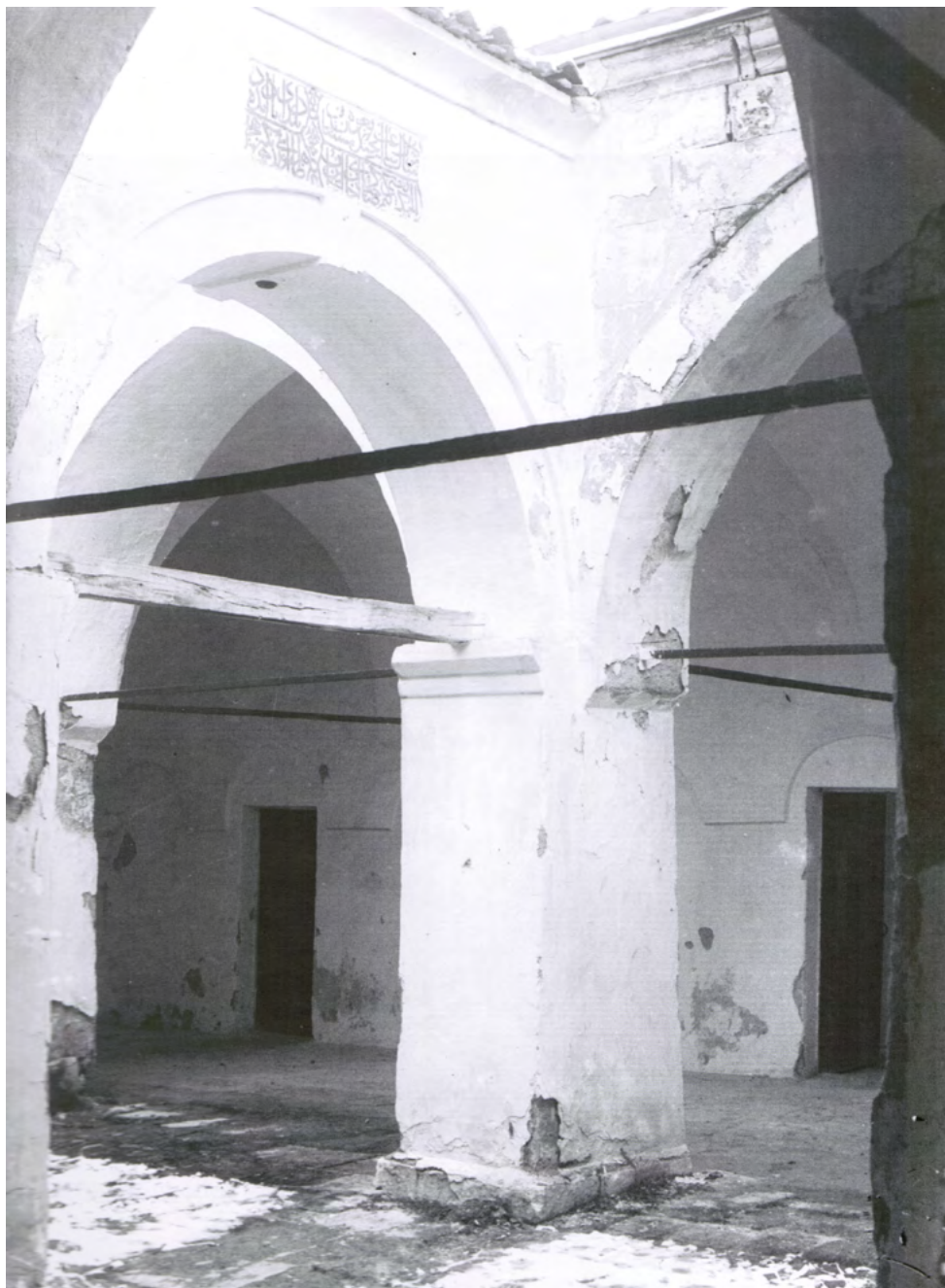
Рис. 2. Зынджирлы медресе. Колонны внутреннего двора. Вид с северо-востока. Фото 1928 г. [по: 7, с. 63, рис. 625]
