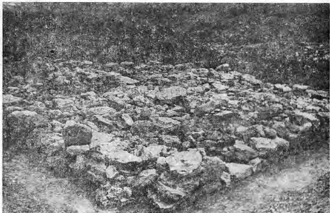
Рис. 44. Башня на западном фланге оборонительных сооружений акрополя. Вид с юго-запада.
