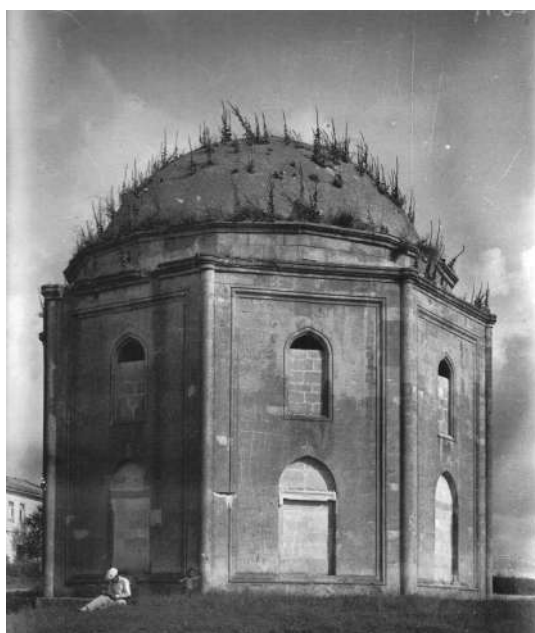
Рис. 22. Эски-Юрт. Азиз. Дюрбе «Большой восьмигранник». Вид с северо-запада. Фото 1924 г. [по: 10, с. 19, рис. 12]
