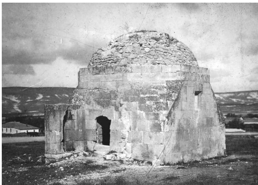
Рис. 4. Эски-Юрт. Азиз. Дюрбе Мухаммед-Шах-бей. Вид с юго-востока. Фото 1924 г. [по: 10, с. 22, рис. 15]
