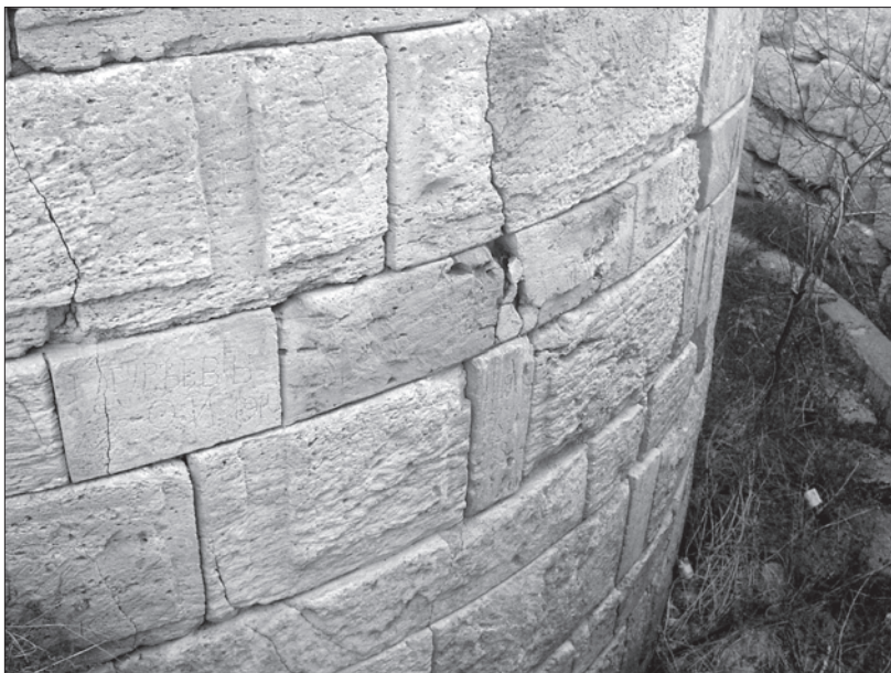
Рис. 13. Паз для вертикального выравнивания кладки (башня Зинона).
