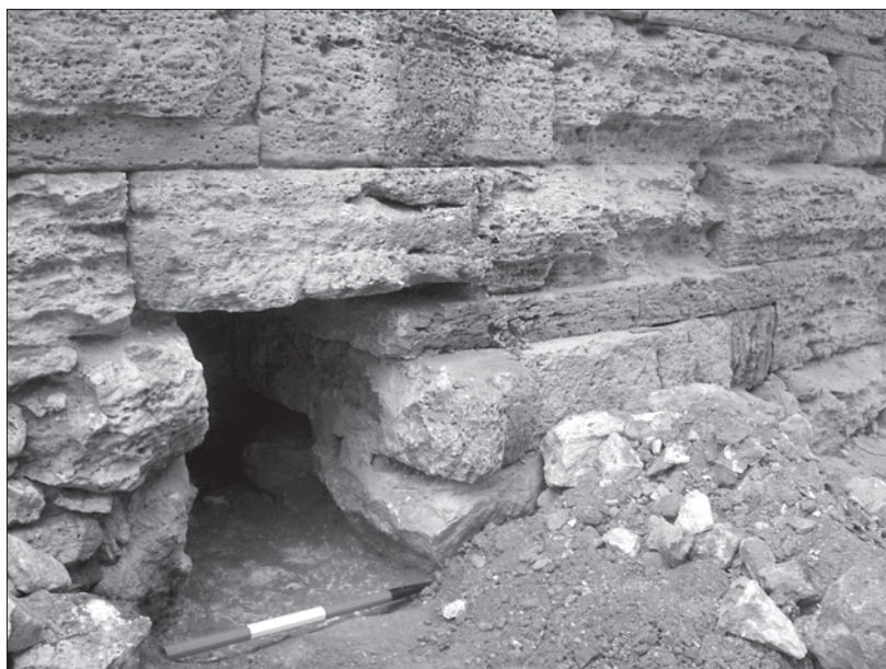
Рис. 9. Соединение разных частей фундамента восточного пилона ворот.
