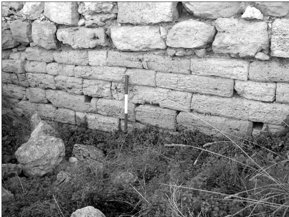
Рис. 28. Часть тыльной стороны куртины 19 первого строительного периода (вид со стороны «цитадели»).
