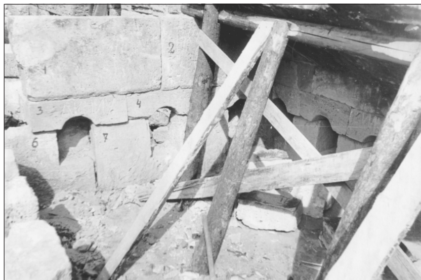
Рис. 11. Внутренняя сторона западной стены склепа № 1013 с нишей.
