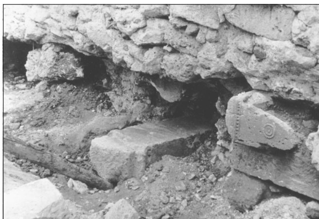
Рис. 7. Первый от башни XV 1 контрфорс, ширину которого составляют две стены, впущенные в кладку протейхизмы.
